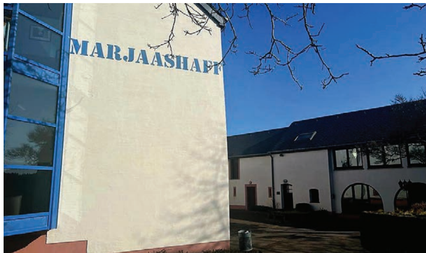
Le nouveau foyer pour mineurs non accompagnés à Liefrange
